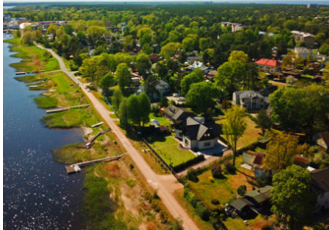
Jauna inženierbūve. 1. vieta. Jūrmalas ūdenssaimniecības attīstība IV kārtā. Pasūtītājs Jūrmalas ūdens, projekts Aqua-Brambis, būvnieks RERE Vide, būvuzraugs Firma L4.
