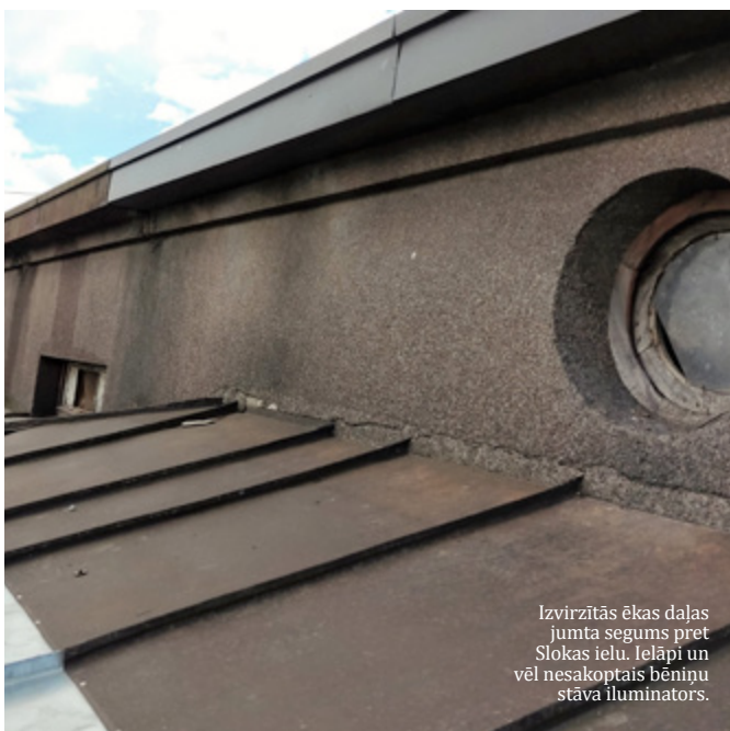
Sienas fragments ar oriģinālo apdari un lokālajiem labojumiem/ielāpiem. Precīzs un komplicēts darbs, jo kaļķu java līp negribīgi.
